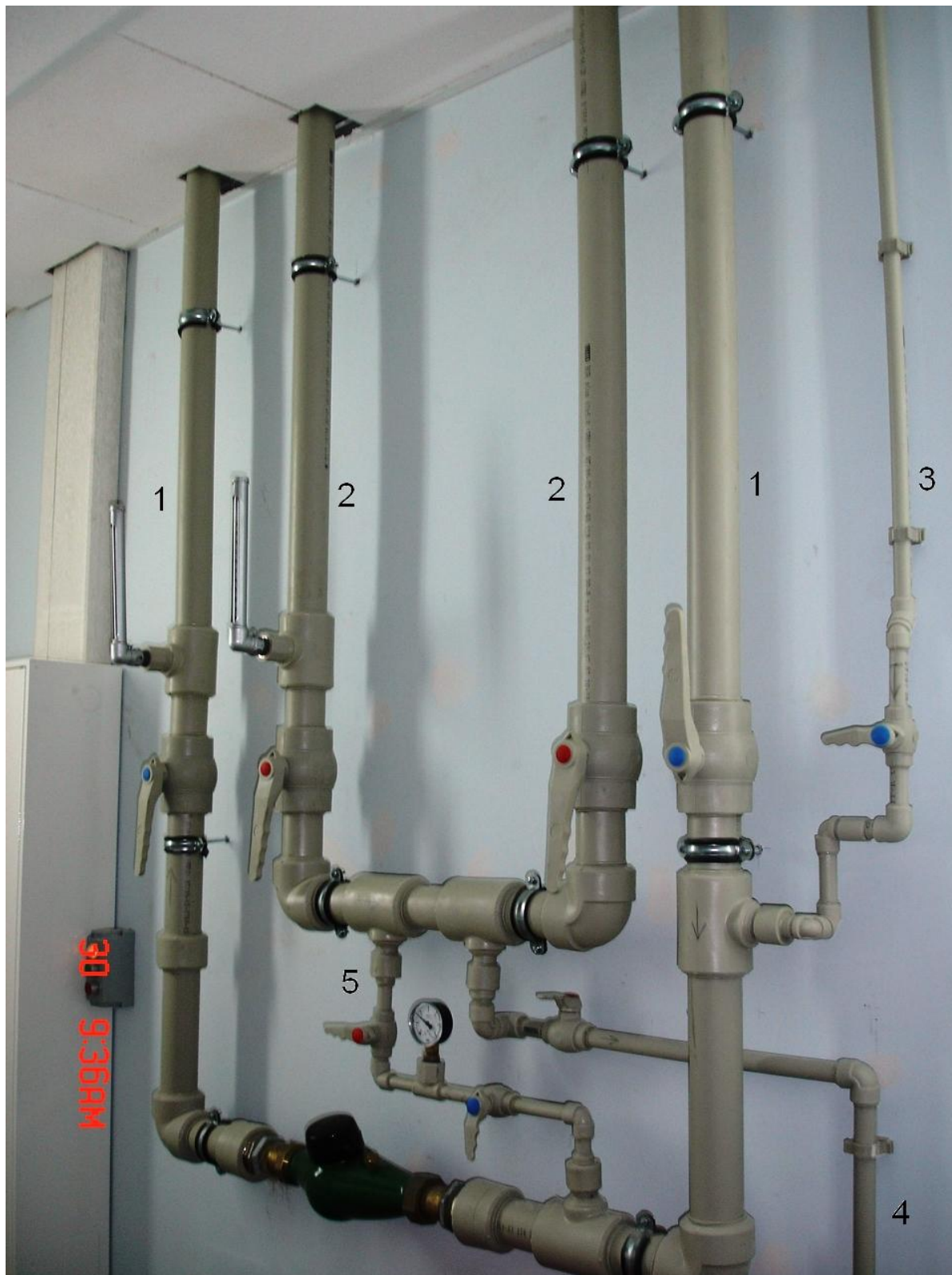
Rys. 6.3. Przykładowe rozwiązanie przyłącza wodnego chłodzenia aparatu przy istniejącym systemie Zamawiającego
